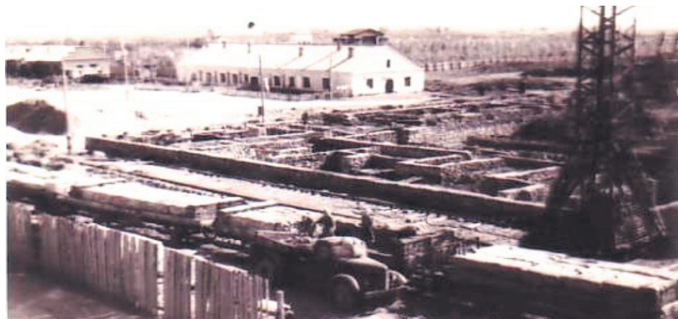
▲ Парковая площадь, начало строительства Дворца металлургов. Белое здание на заднем плане — мастерская по изготовлению декоративных элементов домов
