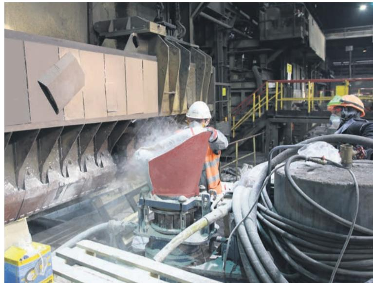
▲ Торкретирование средней механической штукатурки: сухую смесь разводят водой и наносят на поверхность распылителями с дозаторами подачи
